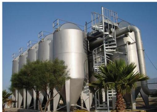
该系统是一款可以自动反冲洗，连续运转的先进过滤系统，内部填入先进催化过滤材料 Katalox Light，可以连续处理过 滤井水、河水等饮用水处理系统。
