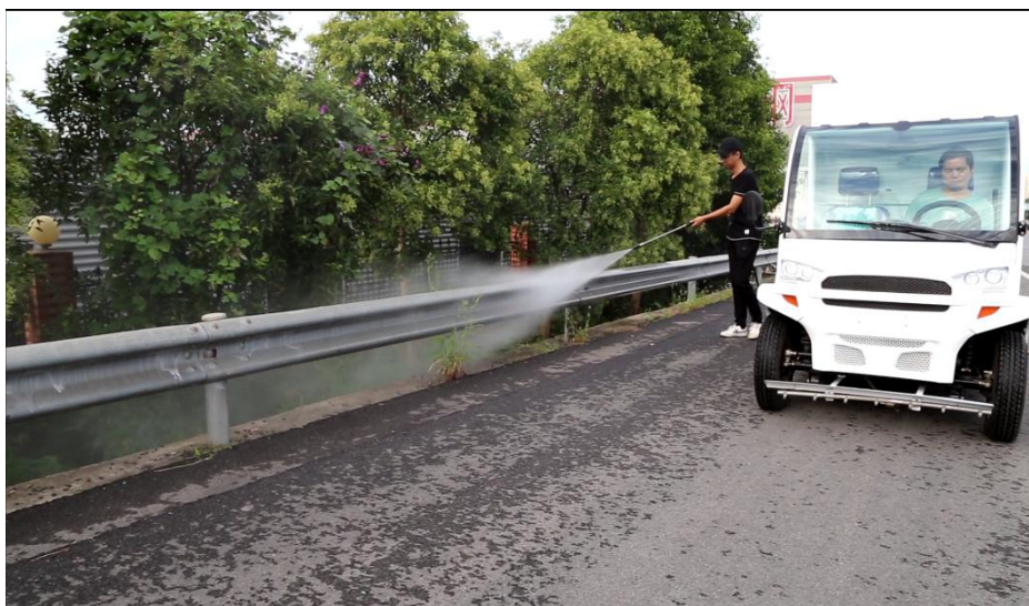
8、墙体 窗户顽固积灰冲洗，让楼体焕然一新。
