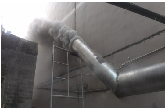
图三 未安装净化器前的排烟效果
