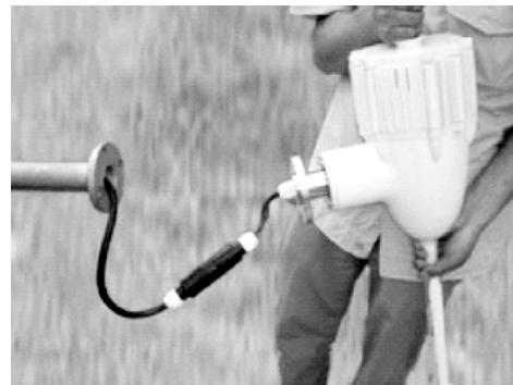
4、将电缆线一端穿出塔杆。
